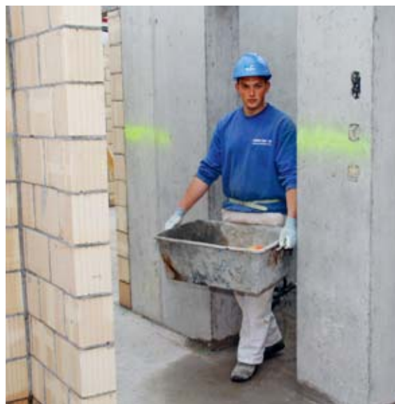
Les gants offrent une protection efficace contre les écrasements, les égratignures, les griffures et les coupures.
